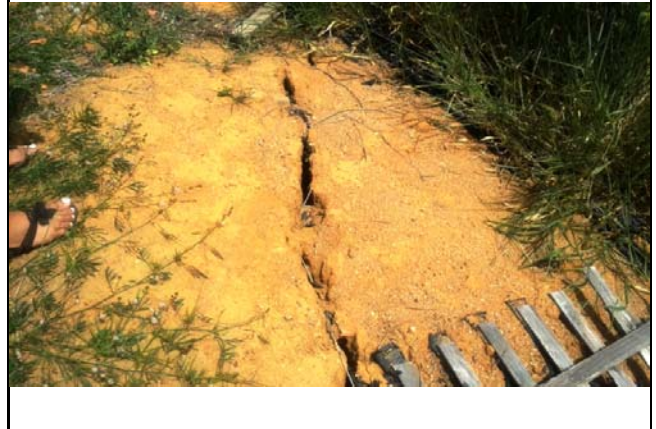
Trinca em terreno observada na parte de trás das moradias. Essa trinca passa no quintal de todas as moradias inclusive, causando trincas nos muros das mesmas.
