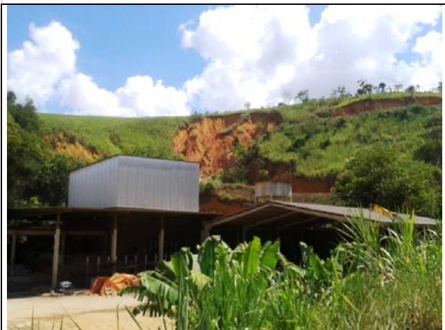
Ravina em talude natural de mais de 20,0 metros de altura e 60° de inclinação. A ravina apresenta dimensões, aproximadas, de 5,0 metros de largura por 4,0 de profundidade.
