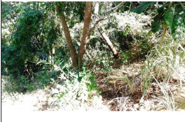
Árvore inclinada em talude natural, este variando de 6,0 a 12,0 metros de altura e com inclinação de aproximadamente 40°. Há presença de gramíneas cobrindo boa parte do talude natural.
