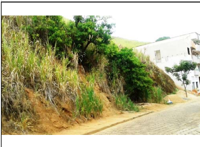
Escorregamentos planares em talude natural de aproximadamente 15,0 metros de altura e 60° de inclinação. Nota-se árvores inclinadas.
