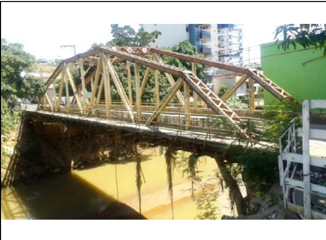
Ponte para travessia de carros e pedestres encontrada ao lado da área mapeada.
