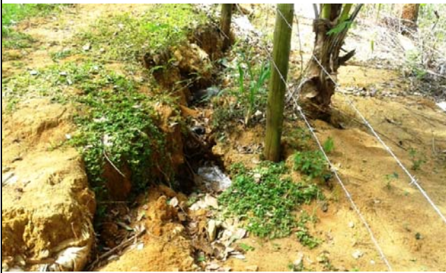
Trincas no terreno encontradas no topo do talude natural, bastante próximas ao degrau de abate.
