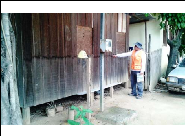
Na base do talude há uma parte da área mista (escorregamento e inundação), onde pode-se observar a marca d'água atingindo até 1,2 metros de altura na parede externa da moradia.
