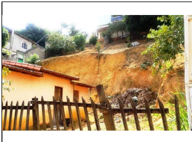
Talude de corte com 6,0 metros de altura e 80 graus de inclinação. Presença de moradia na base, distante 2,0 metros e no topo, distante 4,0 metros.
