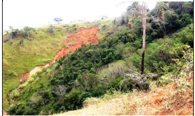
Ravina observada na meia encosta, indo em direção à base do talude natural. Possui dimensões aproximadas de 25,0 metros de largura por 50,0 metros de extensão.
