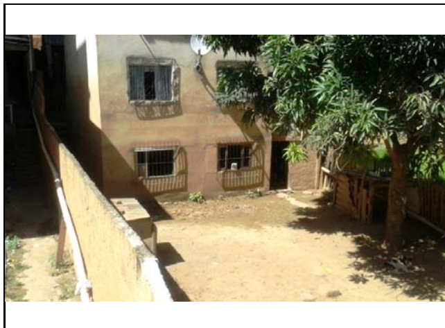
Marca d'água de aproximadamente 2,0 metros de altura em moradia que se encontra dentro da área de inundação do Rio Doce. Essas moradias ficam distantes aproximadamente 150,0 metros da margem do Rio Doce.
