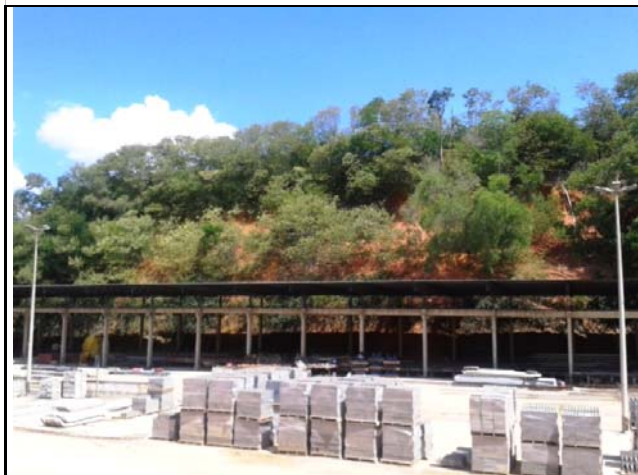
Talude de 6,0 metros de altura e 70° de inclinação com barracão distante 3,0 metros da base. Apresenta vegetação arbustiva e gramíneas.
