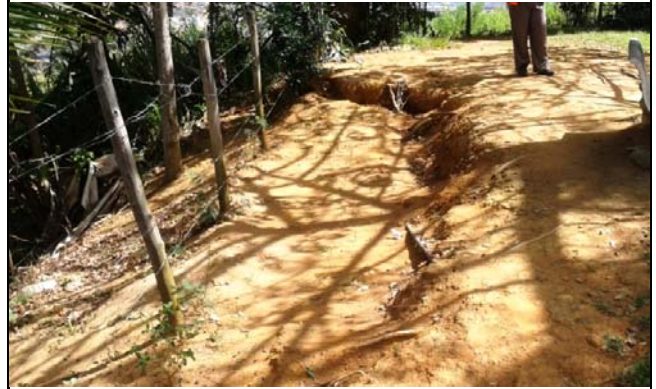
Degrau de abate encontrado no topo do talude natural. A aproximadamente 10,0 metros de distância encontra-se o posto de saúde do bairro.
