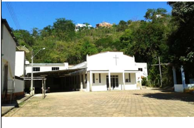
Encosta natural de, aproximadamente, 12,0 metros de altura e 50° de inclinação. Apresenta vegetação composta por gramíneas e árvores de pequeno e grande porte. Há moradias localizadas a jusante da encosta, distantes 3,0 metros da base desta.
