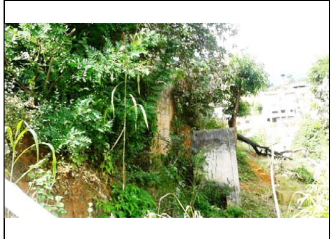
Muro de contenção em talude de corte de altura aproximada de 4,0 metros. O restante do talude possui inclinação aproximada de 60°. Observa-se neste talude a presença de árvores inclinadas.
