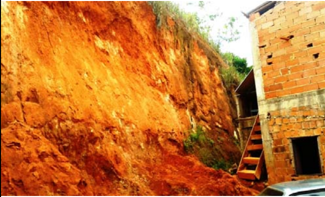
Talude de corte de altura aproximada de 6,0 metros e 80° de inclinação com presença de cicatrizes planares e processo erosivo bastante evidente. Nota-se presença de moradias na base do talude.
