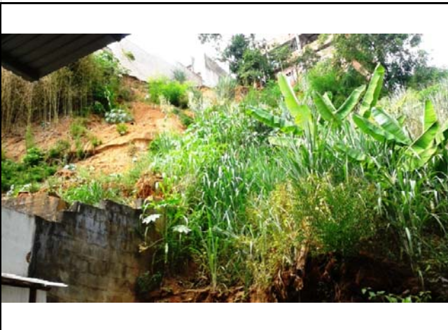
Cicatriz de escorregamento planar em talude de corte de altura aproximada de 10,0 metros e 70° de inclinação. Processo erosivo bastante evidente.
