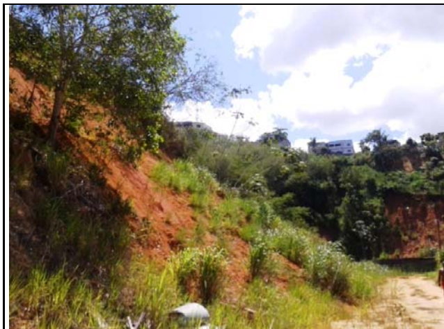
Talude natural de 10,0 metros de altura e 70° de inclinação com cicatriz de movimentação de massa do tipo planar e depósito pretérito na base e apresenta algumas árvores de pequeno porte inclinadas.
