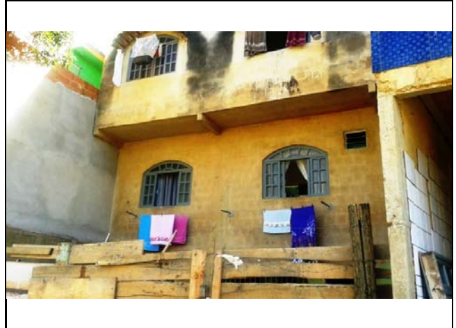
Marca d'água em residência. O rio teve seu nível aumentado em aproximadamente 11,0 metros na última chuva (dezembro de 2013), sendo que a altura da água atingiu a frente da moradia numa altura de aproximadamente 6,0 metros.
