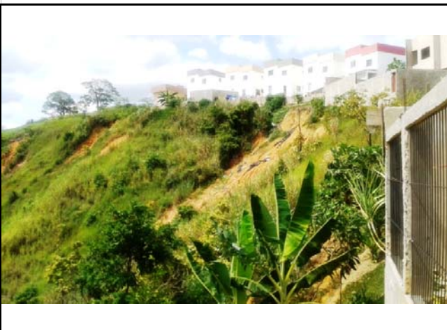
Cicatrizes de escorregamentos planares em talude natural de altura aproximada de 40,0 metros e 70° de inclinação. Observa-se, também, processo erosivo bastante acentuado.
