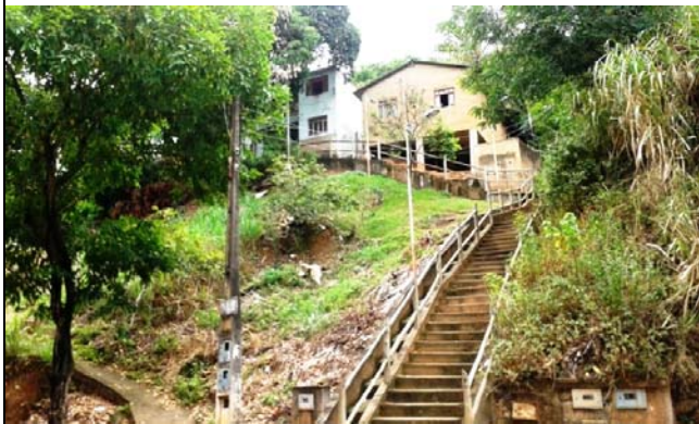
Escadaria de acesso às moradias situadas na área, com presença de escada d'água em uma das laterais da mesma.
