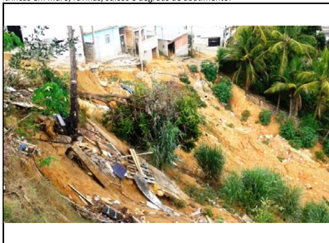
Vista lateral do escorregamento planar já citado na foto 20140424_143458.
