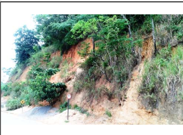
Cicatrizes de escorregamentos planares observadas no talude de corte existente na base da encosta natural.
