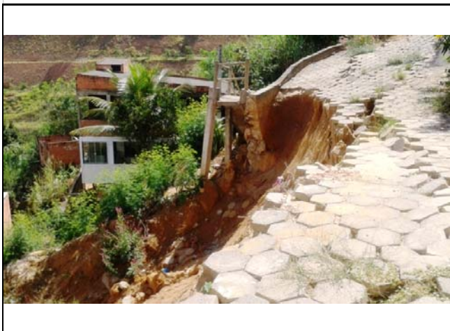
Vista da rua a montante do talude de corte que sofreu escorregamento.
