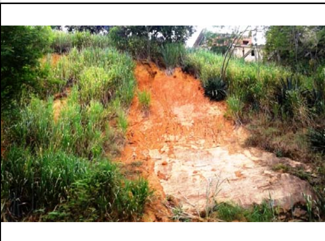
Cicatriz de escorregamento planar em talude natural com presença de rocha localizada na base.
